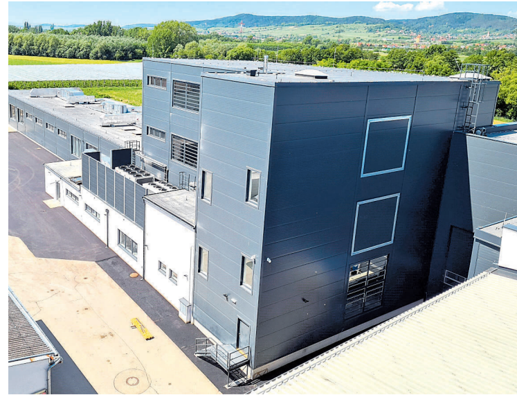
Die neue Fabrik der Gutschermühle ist fertig. Mitte Juli soll dort die Produktion starten. Dann können in Traismauer erstmals auch Erdnuss-Riegel produziert werden können. Foto: Gutschermühle
